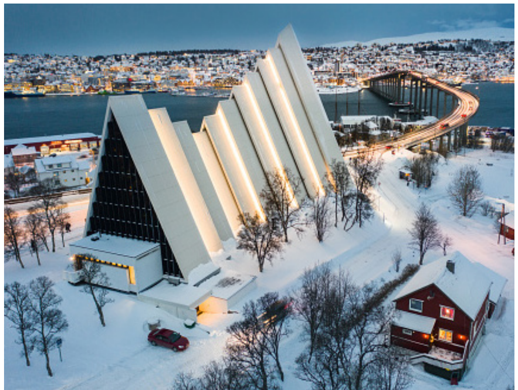
Tromsø Bridge Tromsøbrua, Norway
